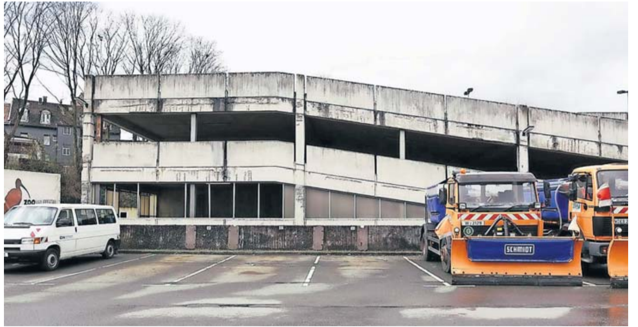
Das marode Parkhaus wird in einem ersten Schritt abgerissen.
